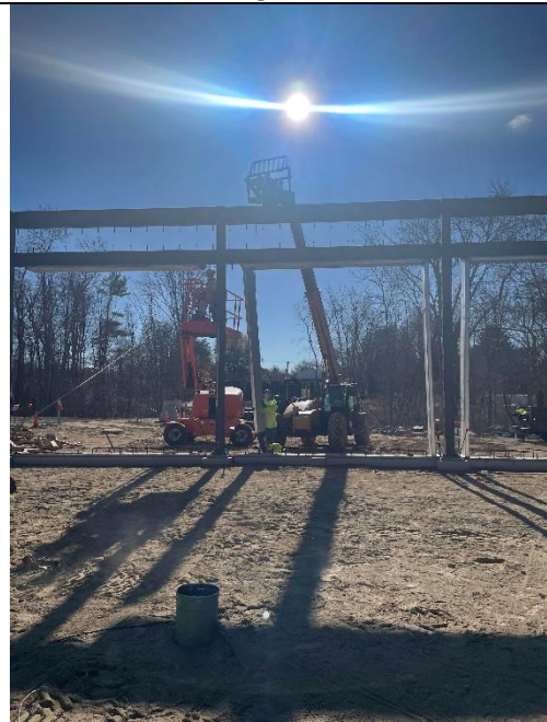
11.20.24 Steel Door Frame Install
